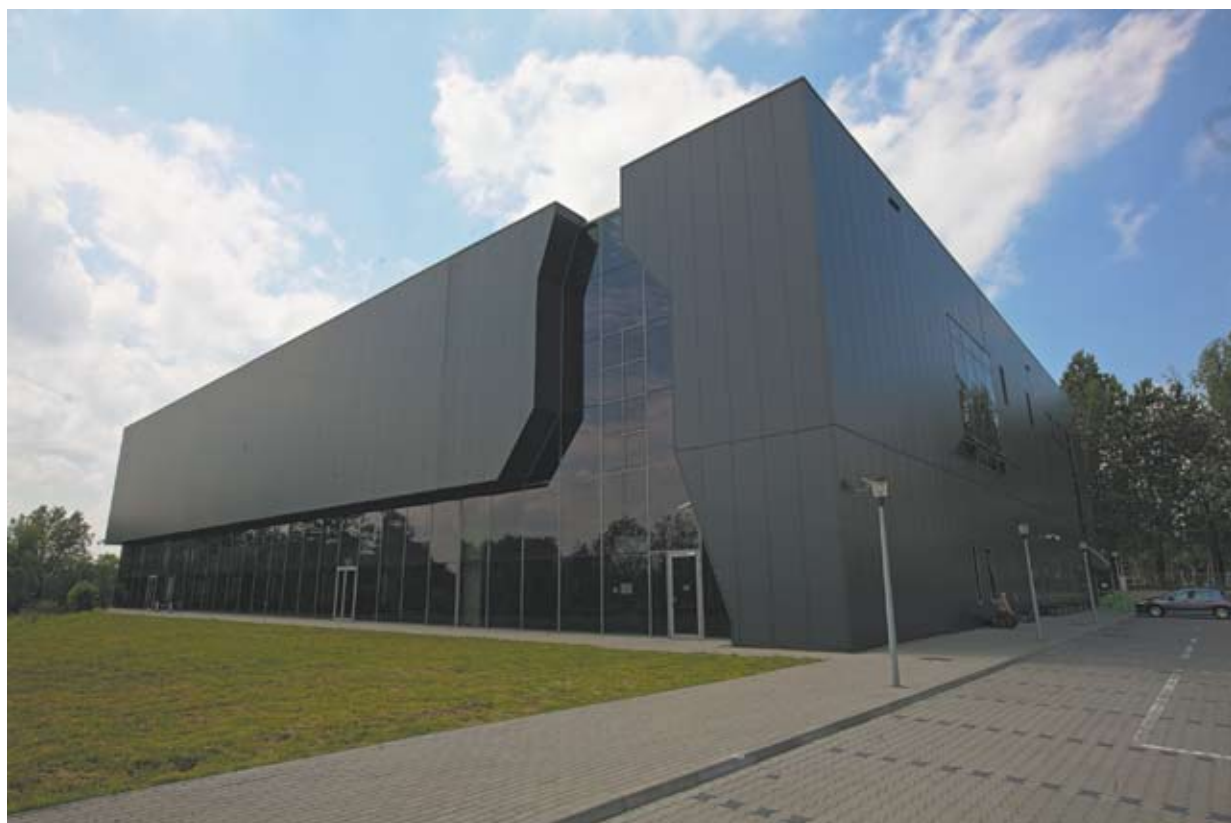
Budowa hali w Szombierkach kosztowała 20 mln zł.
