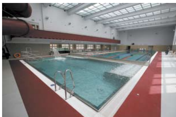
Basen po remoncie
