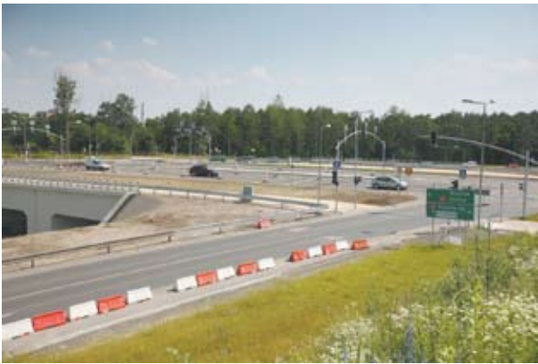
Wiadukt nad obwodnicą
